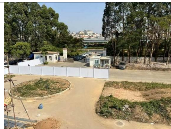
项目东面空地
