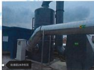
废气净化器
