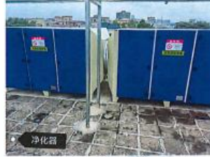
废气净化器
