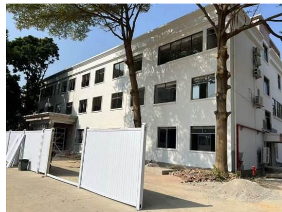
项目北面办公楼
