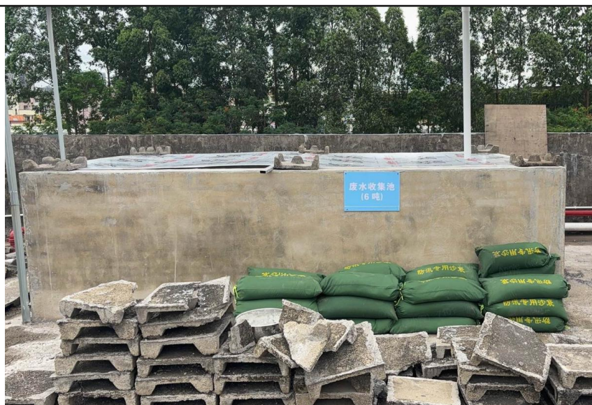
小废水收集池
