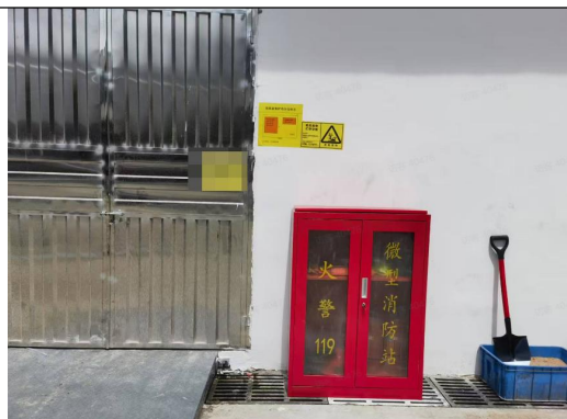
危险废物暂存间大门
